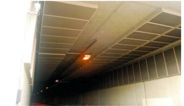
Abb. 9: Unterflurtrasse Lendorf mit SPAS-Filterelementen
